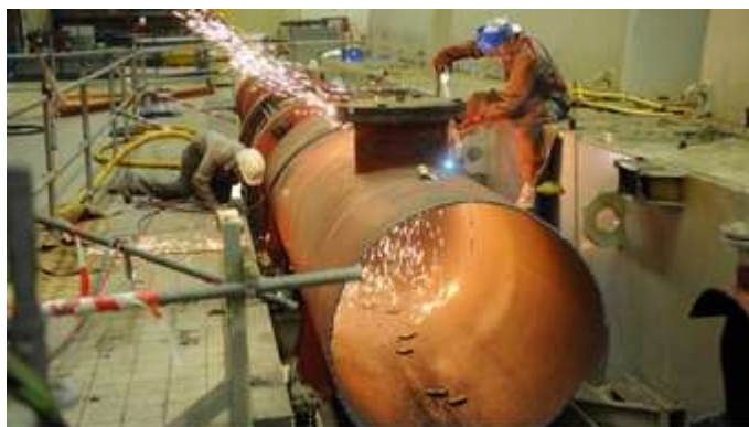
Demontážní práce ve strojovně odstavené jaderné elektrárny © dpa
