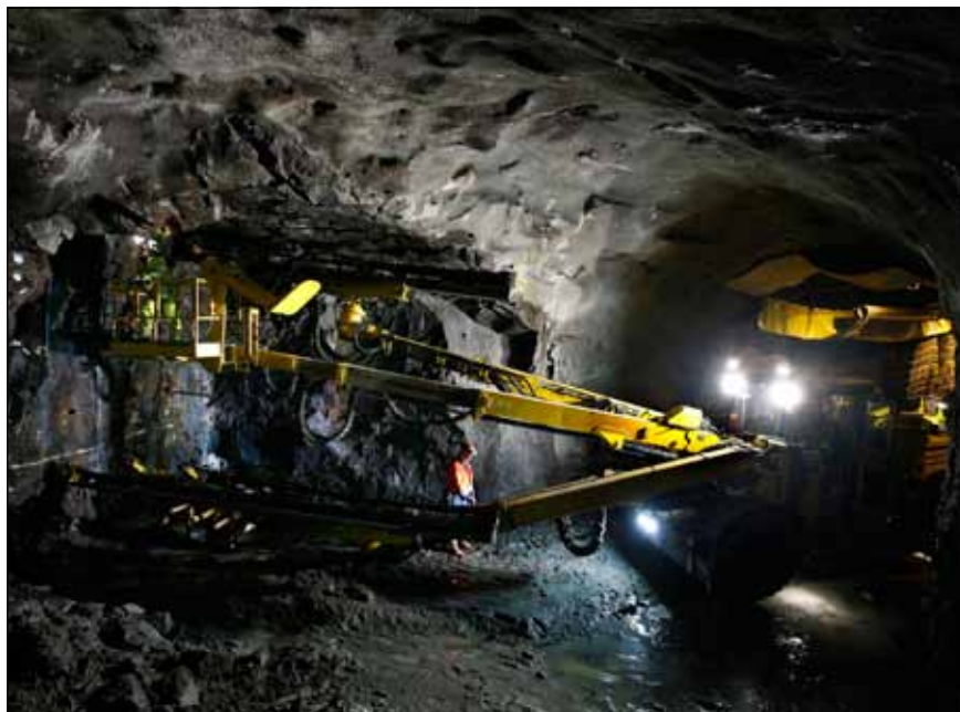
Ražba podzemních štol.
