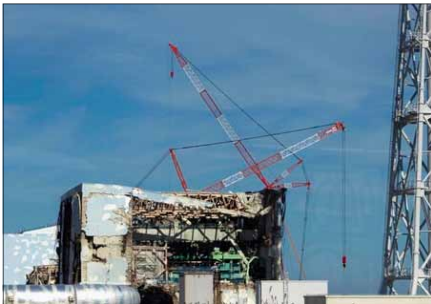
Jeden z havarovaných bloků ve Fukušimě.
