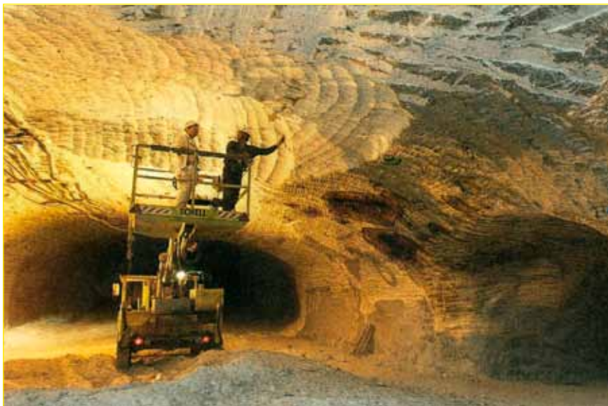
Podzemní prostory meziskladu vyhořelého jaderného paliva v Gorlebenu.
