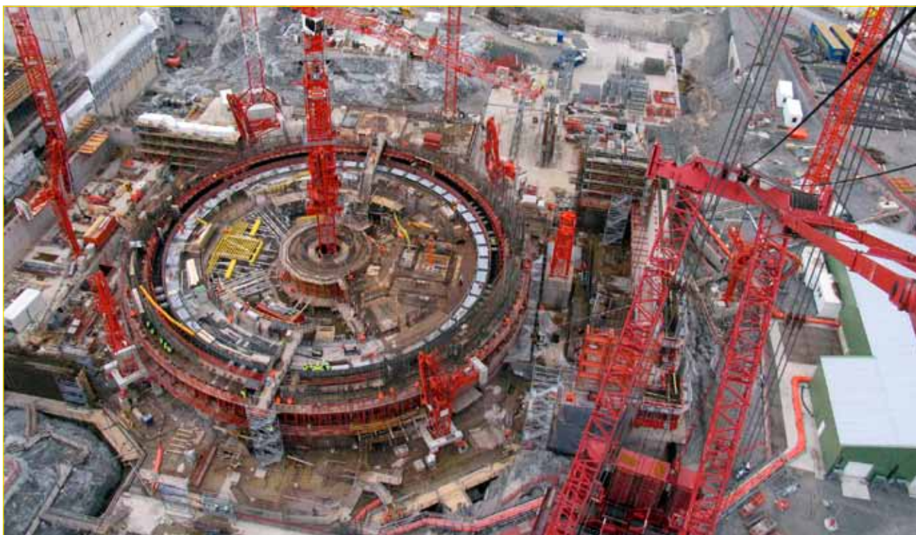
Stavba EPR ve finském Olkiluoto.
