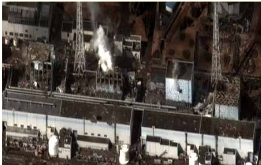
Družicový snímek jaderné elektrárny Fukušima Daiiči.
